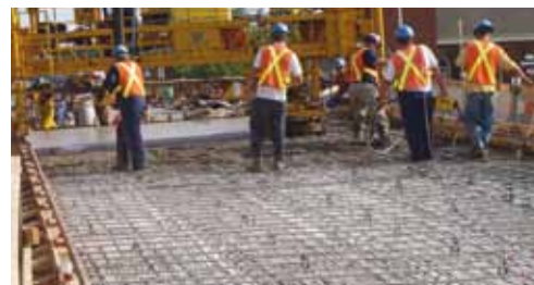
Coulée des dalles
